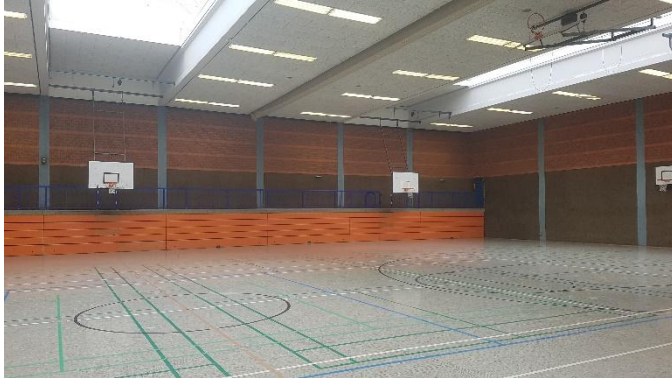
Sporthalle BBS in Varel - Innenansicht
